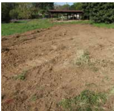
④ 太陽光パネルの撤去完了
