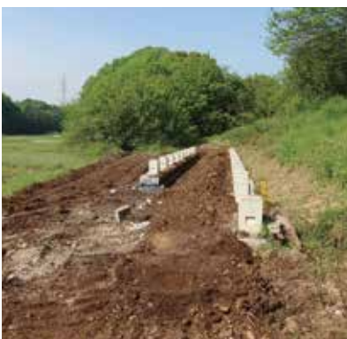
⑧ 太陽光パネル撤去中基礎のみ
