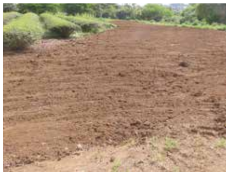
⑤ ⑥ ⑦ 太陽光パネル撤去覆土後
