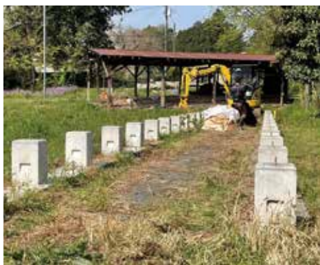
④ 太陽光パネル撤去基礎のみ
