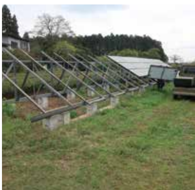
⑤ 太陽光パネル撤去中
