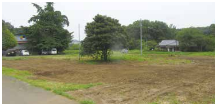
7月倉庫・旧牛舎解体工事完了。左奥は公会堂。老朽化した建物の解体工事により村の環境は整備されました。
