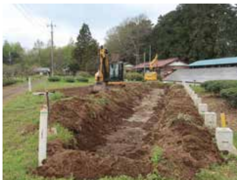
②③ 太陽光パネル撤去中
