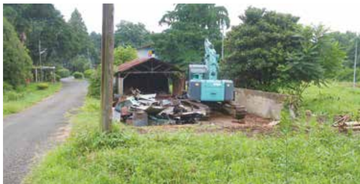
倉庫解体工事中
