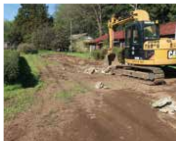
① 太陽光パネル撤去ほぼ終了
