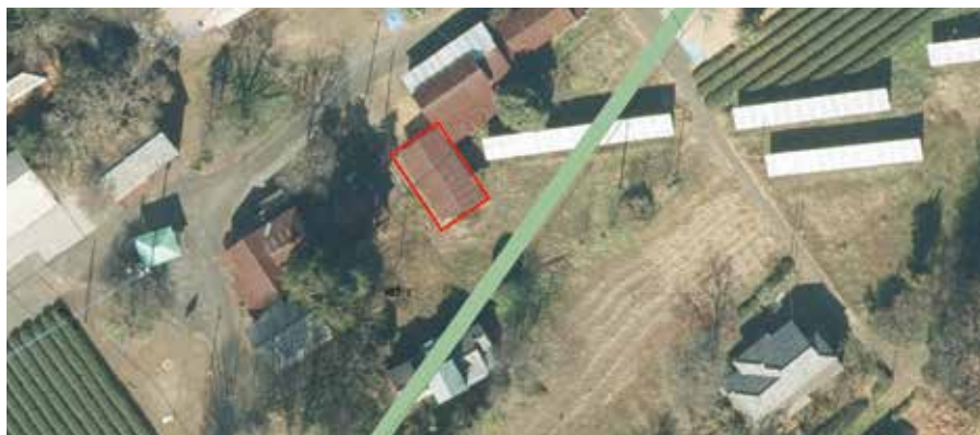
□の建物が農地に建築されている倉庫。
