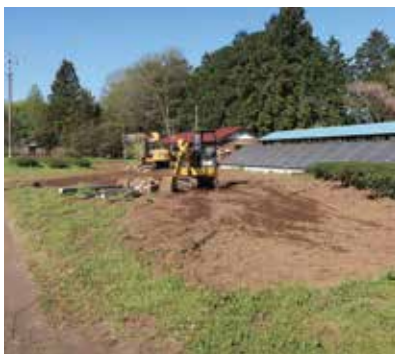
②③ 太陽光パネル撤去ほぼ終了
