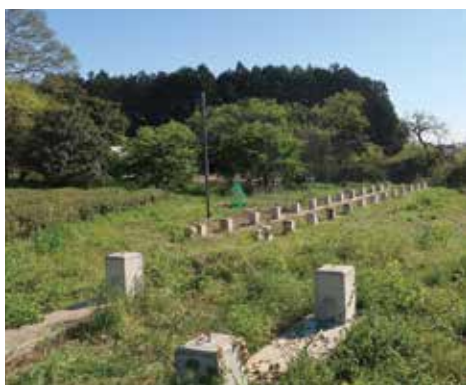
⑦ 太陽光パネル基礎のみ
