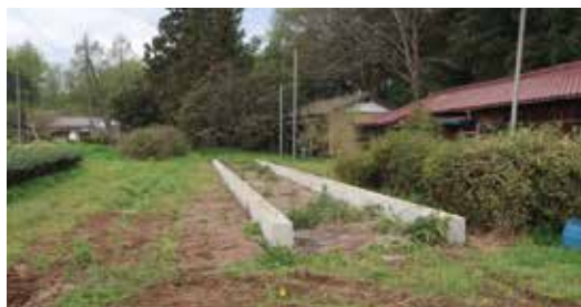
① 4月下旬太陽光パネル撤去工事着手・基礎のみが残っている
