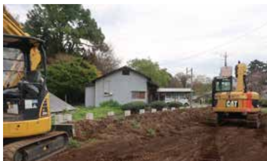
②③ 太陽光パネル撤去中
