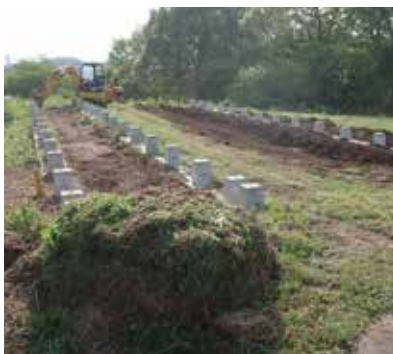
⑤ ⑥ 太陽光パネル撤去中基礎のみ
