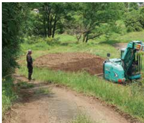
6月10日追加パネル撤去工事
