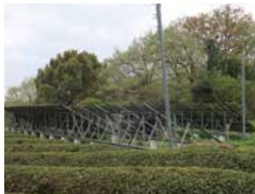
太陽光パネル撤去工事
